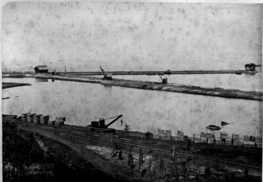
Visão da Ponte de Magad em Mornujão
